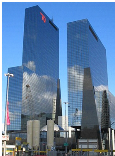
Gebouw Delftse Poort one of the tallest buildings
